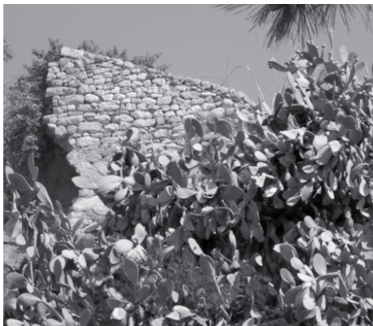
Το ανατολικό σωζόμενο τμήμα του ενετικού τείχους
