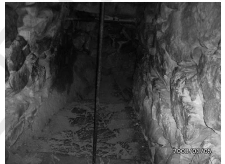
Σήραγγα καθόδου προς υπόγεια δεξαμενή Ακρόπολης Μυκηνών. Διακρίνεται η πρώτη στροφή με το πρώτο πλατύσκαλο
