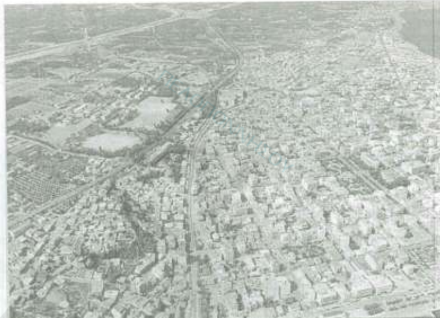
Διαπλάτυνση, εκβάθυνση και εκτροπή του χείμαρρου Ξηριά με αγωγή στη Γ. Παπανδρέου προβλέπει η μελέτη Λαζαριδής που ήδη δημοπρατήθηκε
