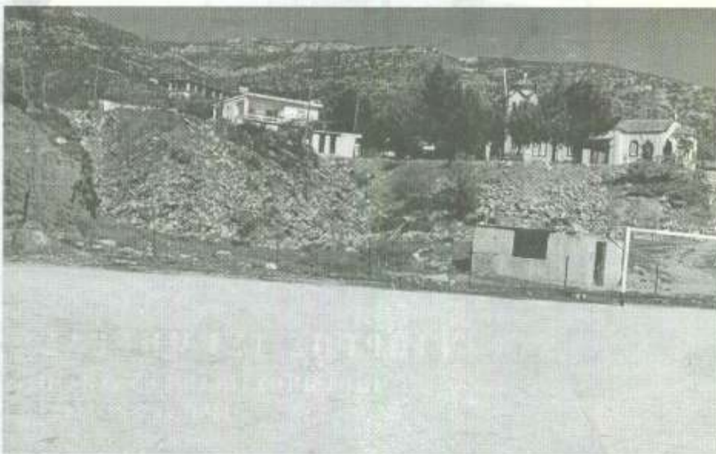
ΓΗΠΕΔΟ, ΜΠΑΖΑ ΤΗΣ ΚΟΙΤΗΣ ΚΑΙ ΕΚΚΛΗΣΙΑ, (ΠΑΡΑΝΟΜΕΣ ΚΑΤΑΣΚΕΥΕΣ κ. ΠΡΟΕΔΡΟΥ) (ΑΠΟ ΝΟΤΙΑ)
