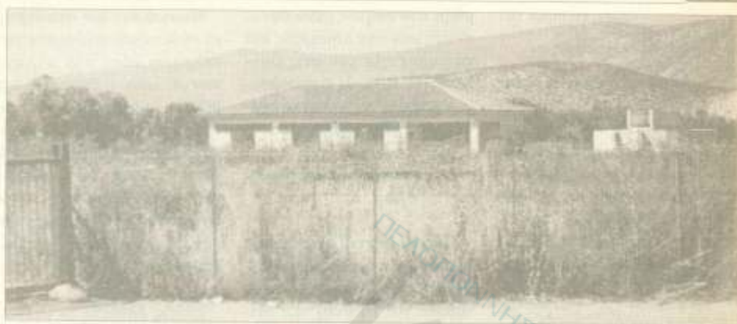
Εγκαταλλεξημένες οι εγκαταστάσεις Κρανιδίου
